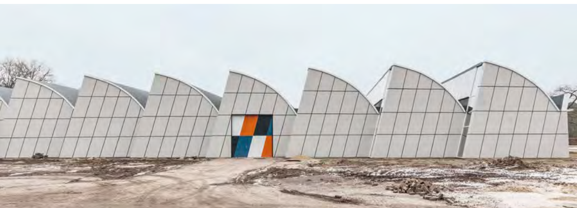
Acht aaneengeschaalde hallen met gebogen zaagtanddaken
